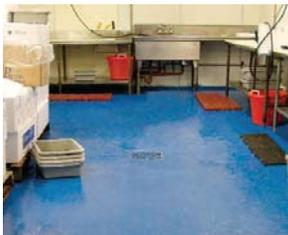
Le sol d'un prestigieux producteur-poissonnier, fournisseur en fruits de mer et en poissons de restaurants et hôtels de luxe, se détériorait rapidement. La peinture s'écaillait et laissait l'eau pénétrer sous la surface du béton, engendrant ainsi de l'humidité et une surface glissante. La surface des quais de chargement était en outre usée par le passage incessant des chariots élévateurs. Il fallait aussi finir le sol d'une annexe récemment construite.
