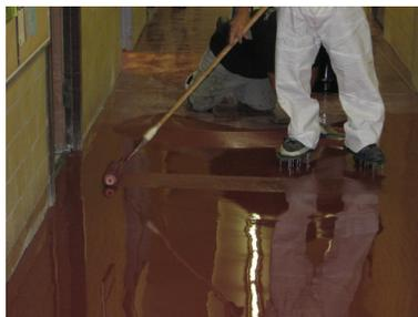
Une fois cette étape complétée, Sikafloor® 261<sup>CA</sup> systèmes 5 et 6 ont été installés. Sika a procédé à l'application d'une finition autonivelante suivie d'une couche de Sikafloor® 2003 pour un fini légèrement antidérapant. Finalement, les joints ont été remplis avec un enduit obturateur semi-rigide de type Loadflex®.
